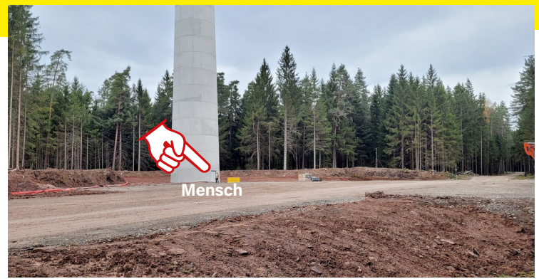
Rund 10.000 m 2 Waldfläche mussten in Seewald einer 240 m hohen Windkraftanlage weichen (November 2025)
