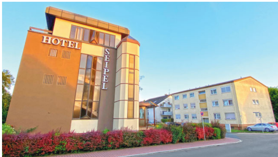
Geht die Sonne über der künftigen Flüchtlingsunterkunft im Ex-Hotel-Seipel auf oder unter? Ein ursprünglich geplanter Anwohnerprotest dagegen verläuft ungewöhnlich ruhig. Foto: Hüll
