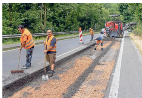
Aktuell ist die L 534 nur einspurig befahrbar. Straßenarbeiter sind vor Ort am Werk. Foto: Alex
