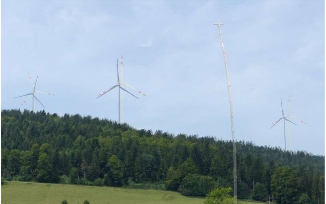
Vorher-Nachher-Vergleich des Windparks Rohrenkopf (Gersbach, Schopfheim) 19
